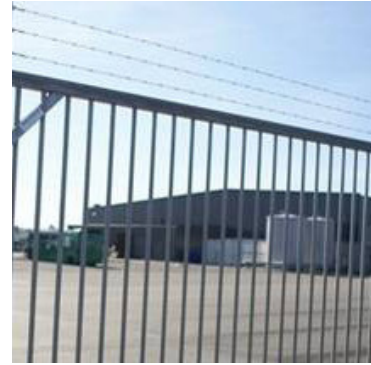
Överklättringsskydd typ taggtråd
